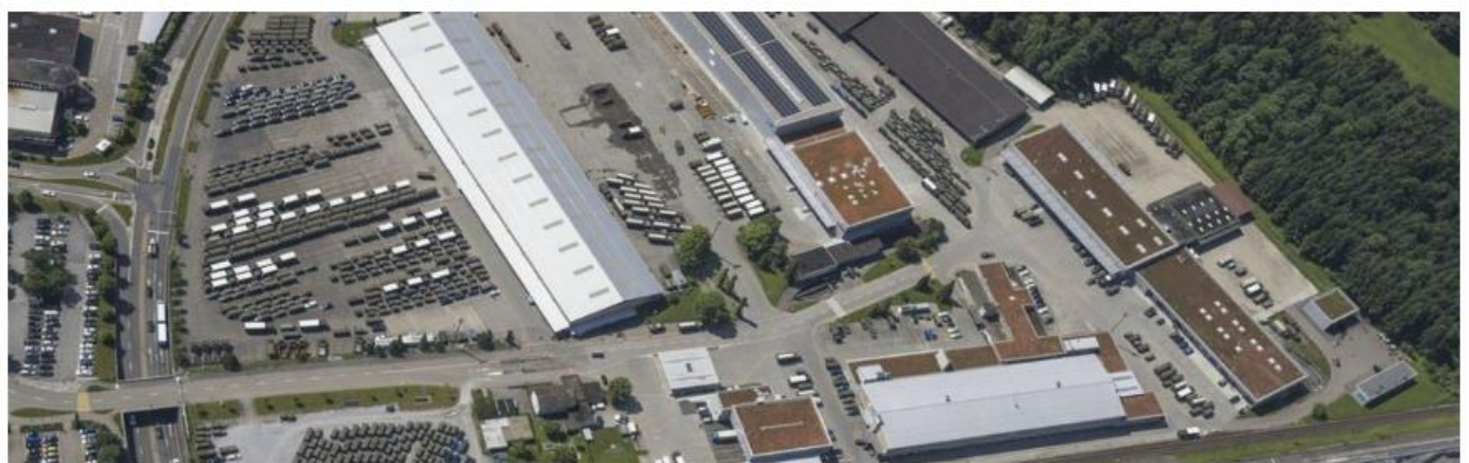
Luftaufnahme des Areal Hinwil
